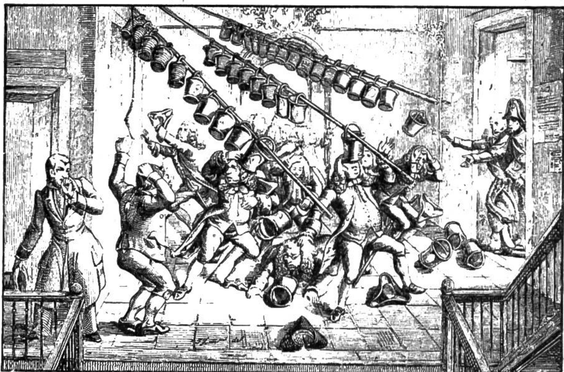
Alte Löschvorrichtung: Herunterholen der Feuereimer durch Zugleine.
