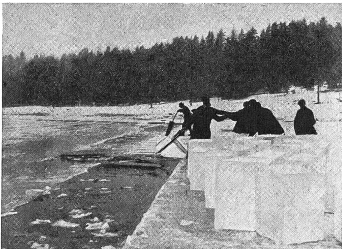
Eisgewinnung auf einem norwegischen Bergsee. Die Eisblöcke werden aus dem Wasser gehoben. In der Mitte hinten sieht man einen Mann, der das Eis mit der großen Handsäge zerschneidet.
