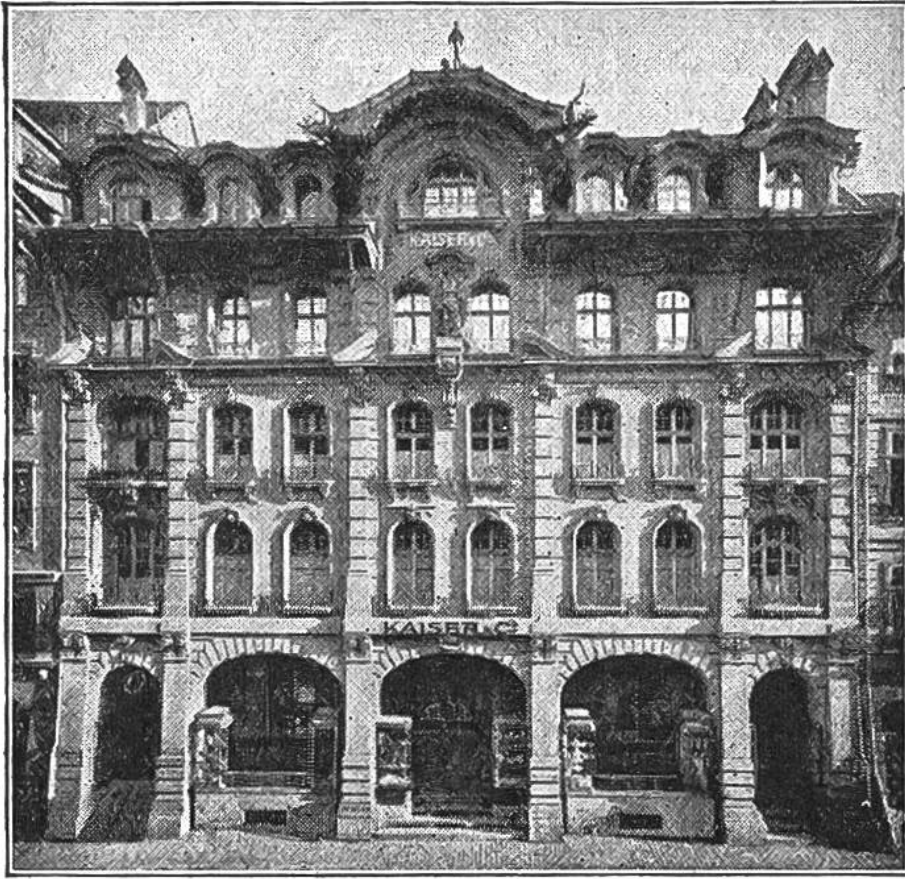
Teilansicht der Geschäftshäuser Kaiser & Co. A.=G.
