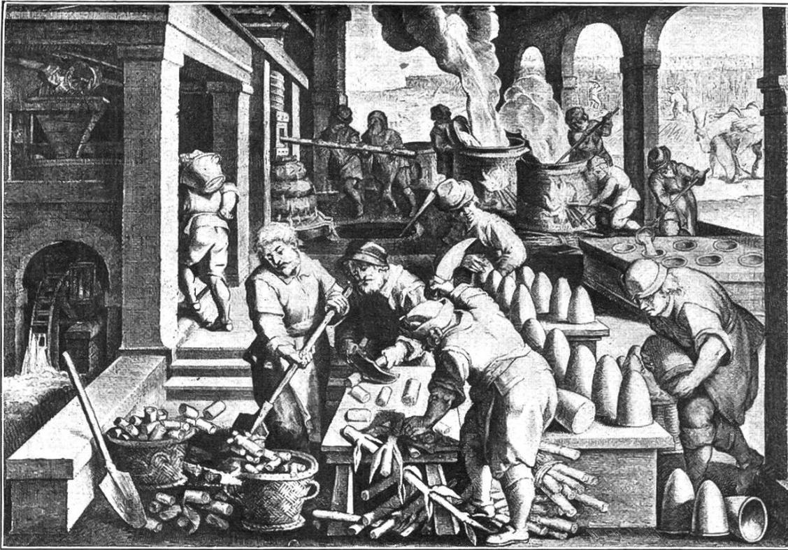
Rohr-Zuckerfabrik im 16. Jahrhundert. Im Vordergrund das Zurechtschneiden der beinahe armsdicken, vollsaftigen Rohre. Die vom Wasser betriebene Mühle (links) zerquetscht die Stücke. Eine Presse, von zwei Männern an einem Hebel gedreht, drückt den Saft aus den Stengeln heraus, wie die Kelter den Wein aus der Traube. Nun geht es ans Kochen des rohen Saftes, der dabei auch gerade geläutert wird. Schließlich können die Zuckerstücke in den charakteristischen Hutformen gegossen werden.
