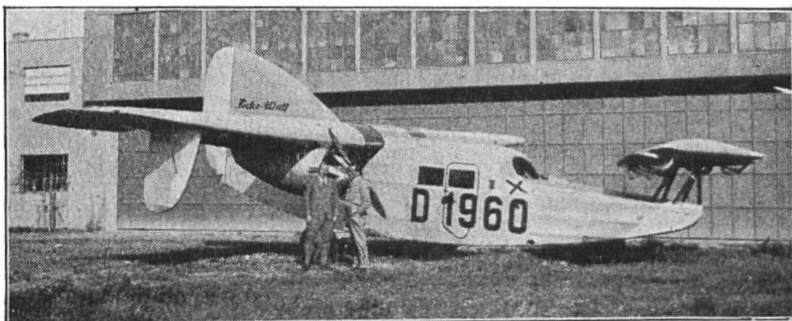
Das neuartige Flugzeug „Ente“, bei dem das Schwanzende nach vorn verlegt ist. Der Führer sitzt an der mit × bezeichneten Stelle über der Ziffer 0. Wer das Flugzeug zum ersten Mal in der Luft sieht, glaubt, es fliege rückwärts.
