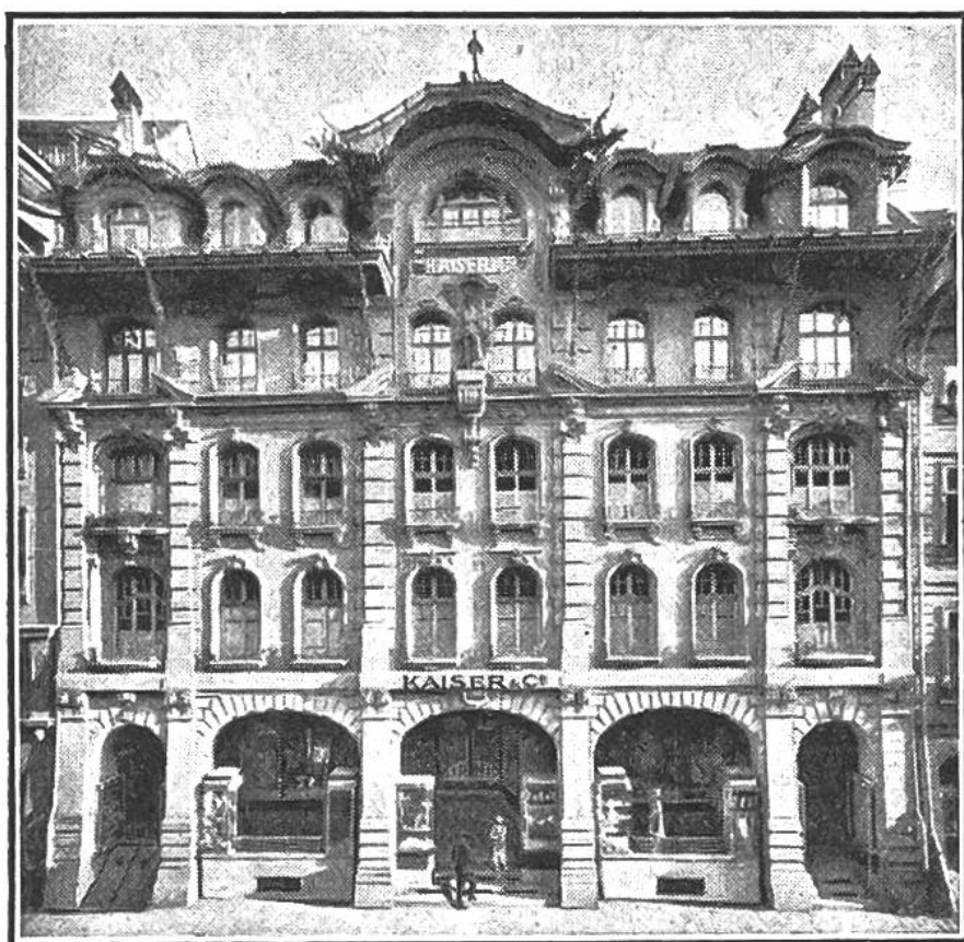
Teilansicht der Geschäftshäuser Kaiser & Co. A.G. Marktgasse 37—43, durchgehend Amthausgasse.
