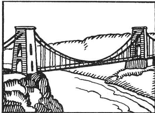
Hängebrücke. Aufhängen der Fahrbahn an Drahtseilen.
