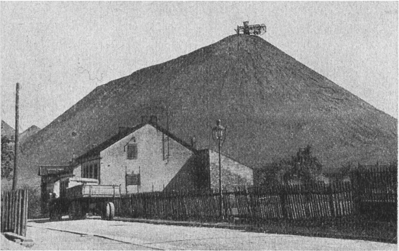
Einer der „Vesuve“ im Saargebiet. Er misst 130 m. Auf seinem Gipfel befindet sich die Kippvorrichtung für die Entleerung der Rollwagen.
