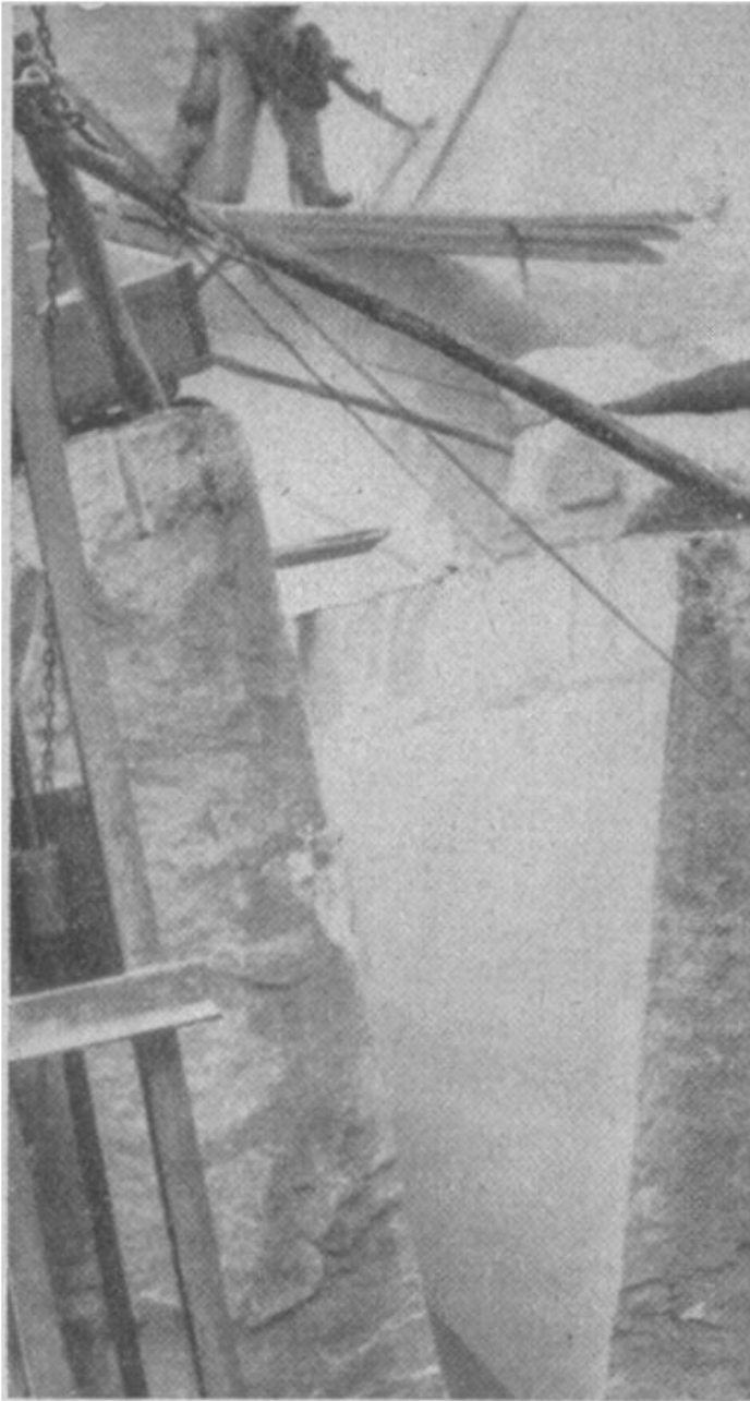
Ein Marmorblock von 50 t wird vom Berg losgetrennt.
