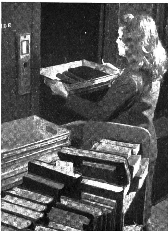
Fahrstühle befördern die gewünschten Bücher in Metallbehältern nach dem Lesesaal.
