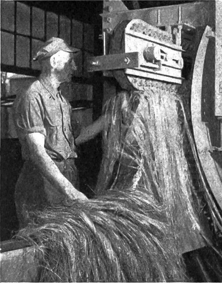
Diese Reinigungsmaschine säubert die Fasern von den Holzteilen.
