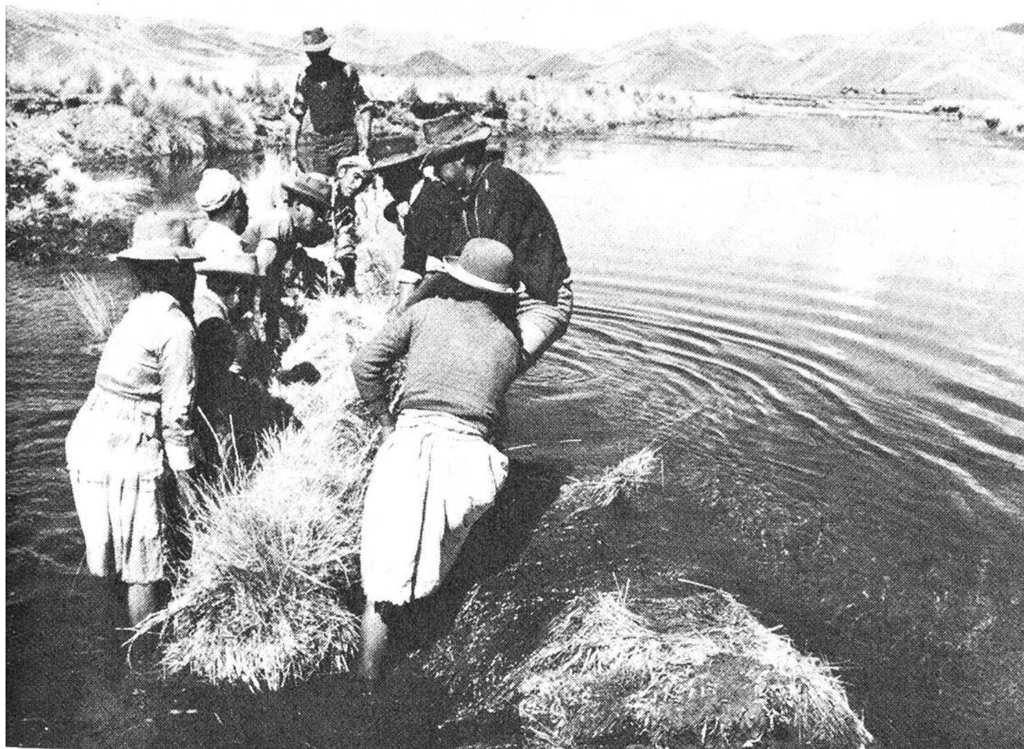
Der schwere «Suche» wird durch das eiskalte Wasser geschleppt und auf den unfertigen Damm gelegt.
