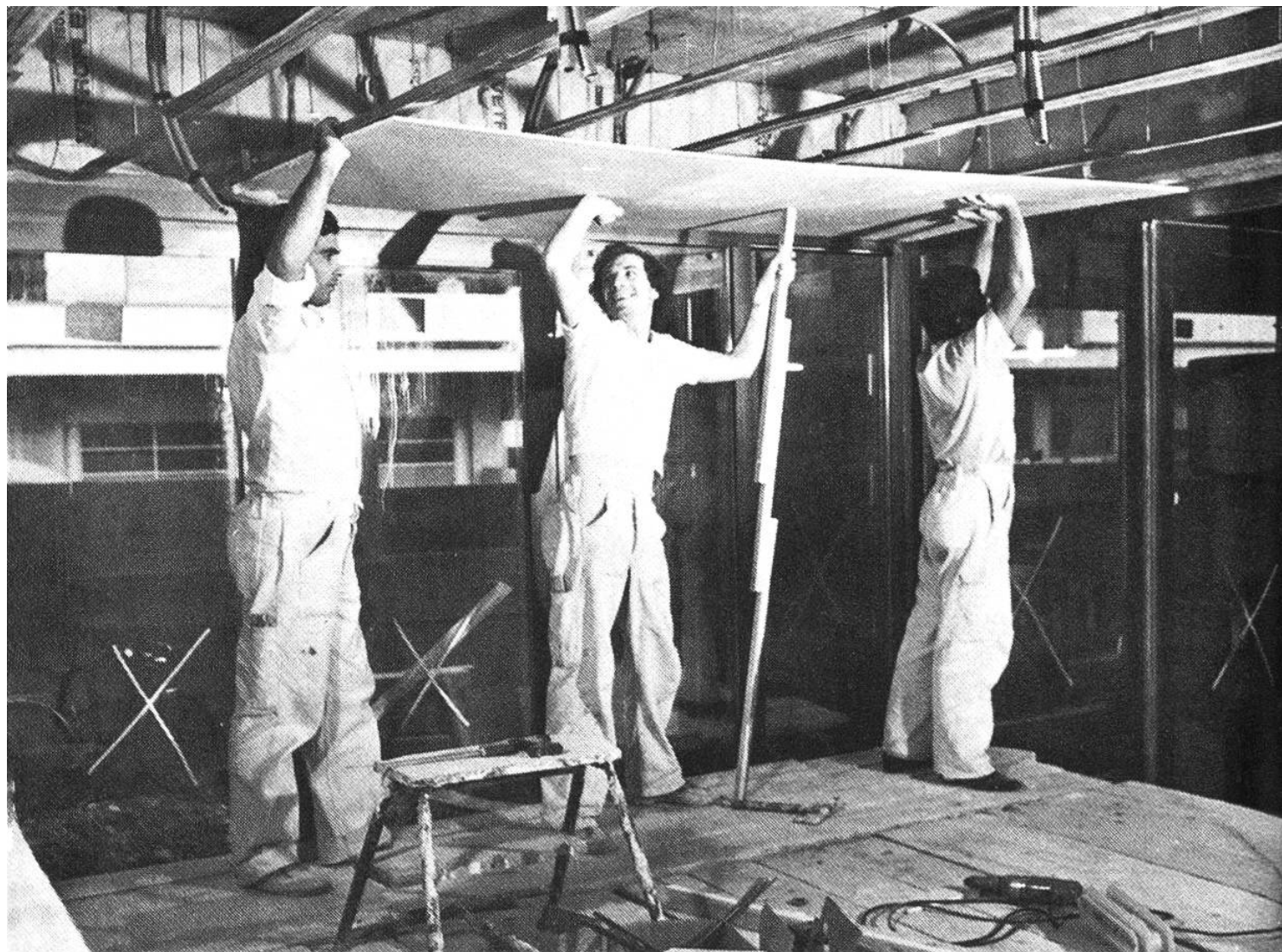
Aus Metallprofilen und Gipskartonplatten wird eine tiefer hängende Decke konstruiert.
