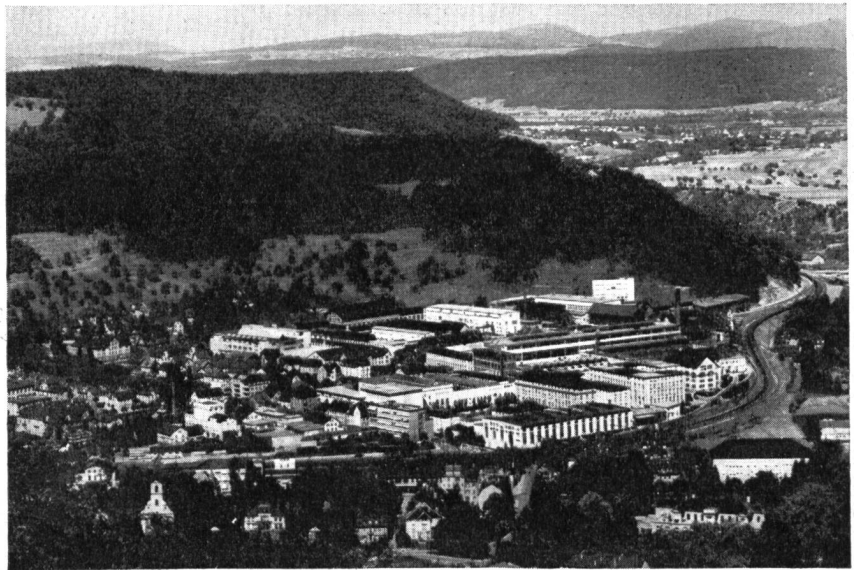
Abb. 2. Die Fabrikanlage der Firma Brown Boveri im Industrieort Baden. Heutiger Bauzustand.
