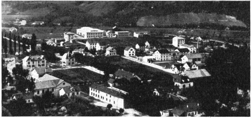
Abb. 1. Die Fabrikanlage der Firma Brown Boveri im Industrieort Baden aus dem Jahre 1892.
