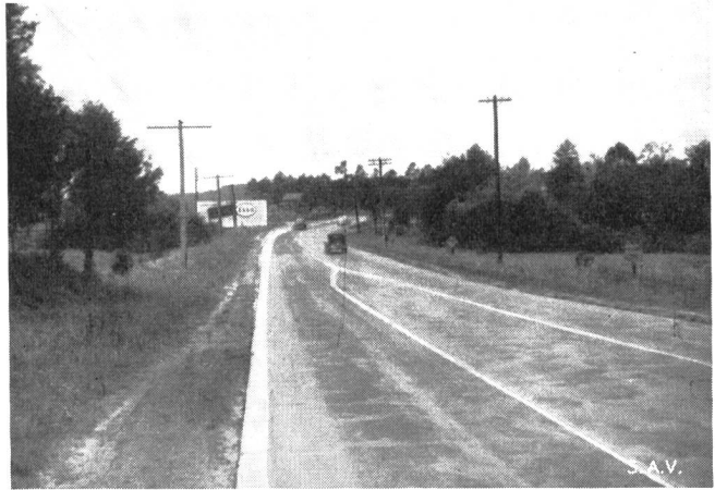
Abb. 5. Bei dieser dreispurigen Strasse ist die mittlere Spur in der Kurve unterdrückt und damit angezeigt, dass das Ueberholen untersagt ist.
