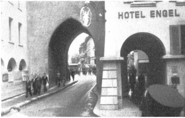
Abb. 11. Das Stadttor mit wenig Verkehr. Durch dieses Tor muss der ganze Strassenverkehr Zürich—Basel geschleust werden.
