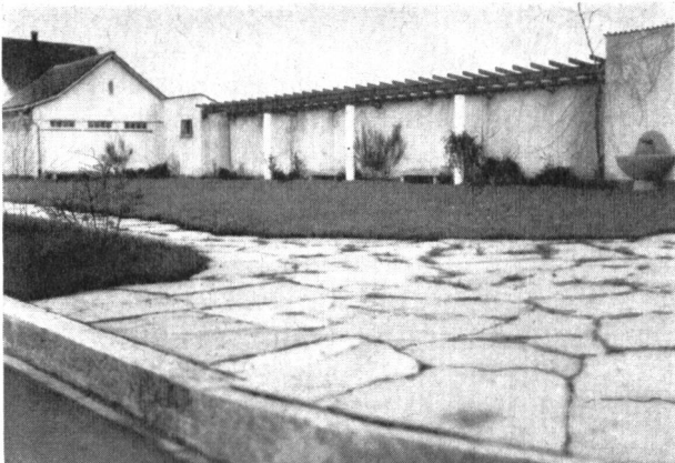
Abb. 3. Die Anlage von der Strasse her gesehen.
