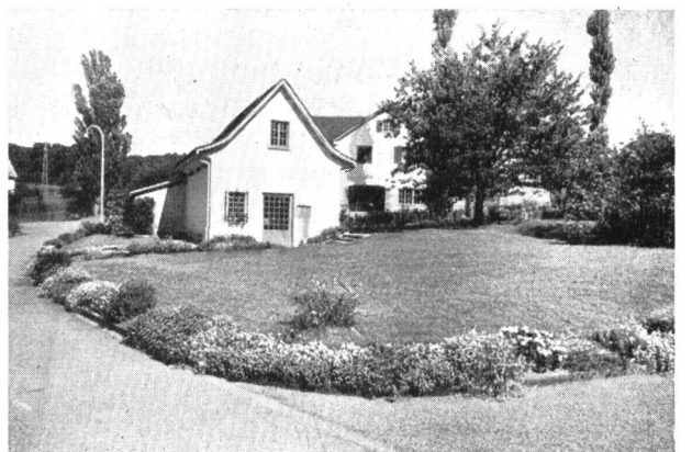
Abb. 9. Die Transformatorstation ist mit dem Dienstgebäude eines Spitals zusammengebaut und fügt sich gut in die Landschaft ein.
