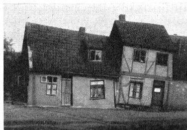
Eines der Häuser, die durch die Senkungserscheinungen bedroht sind.
