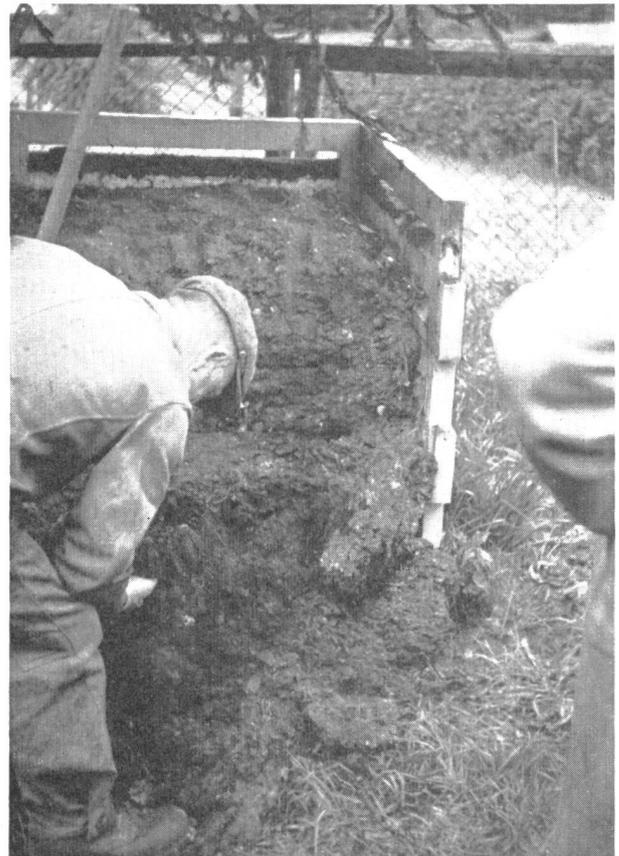
Abb. 5. Rippa-Silo für Kompostierung nicht zerkleinerten Rechengutes aus der Kläranlage St. Gallen. Oeffnung, vollständige Verrottung des sehr komplexen Rechengutes.
