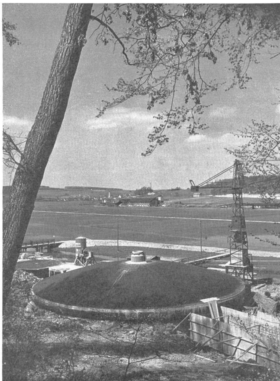
Abb. 7. Fassungsbauwerk über dem Buchbrunnen-Quelltopf.
