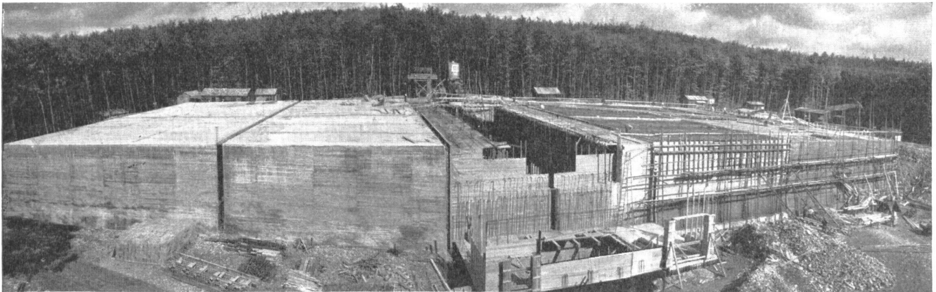
Abb. 8. Hochbehälter Aufhausen im Bau.
