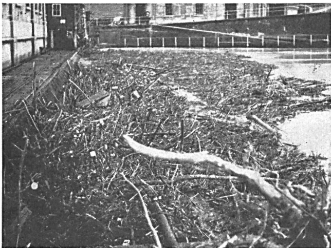
Abb. 2. Geschwemmselanfall (Hochwasser), Kraftwerk Wynau.
