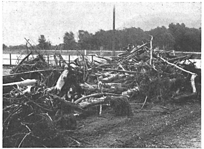
Abb. 3. Natürliches Geschwemmsel (Hochwasser), Kraftwerk Albruck-Dogern.
