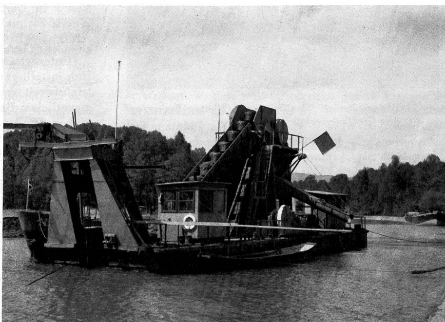
Abb. 17. Der grosse Eimerketten-Schwimmbagger Herkules.
