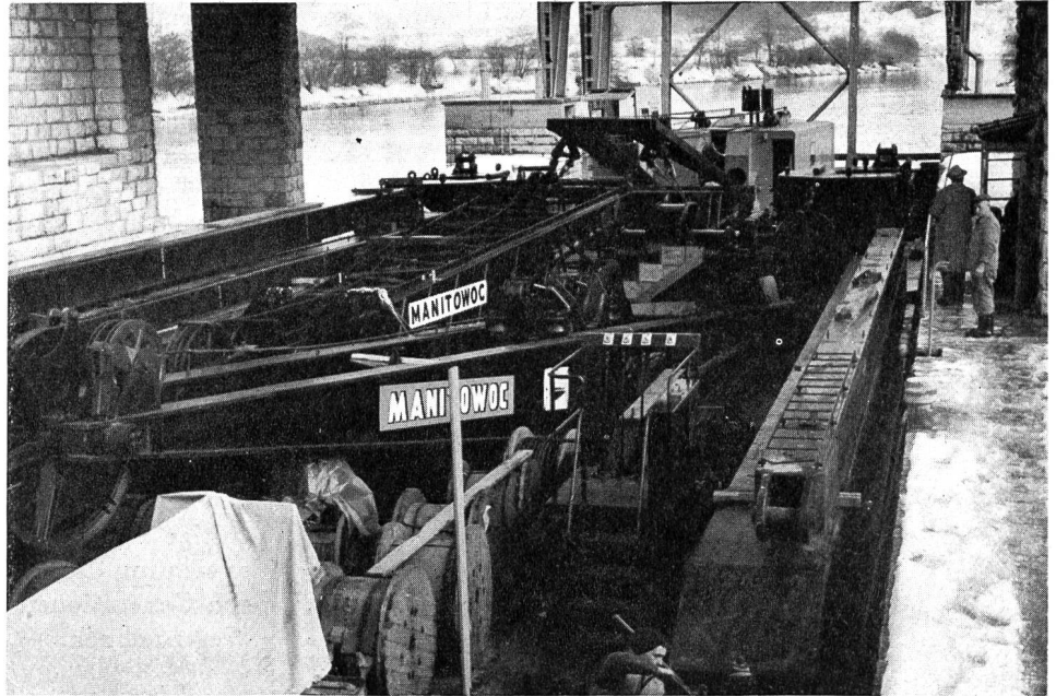
Abb. 19 Der «Manitowoc», nach Mass für die Schiffschleuse in Port gebaut, in der Schleuse.
