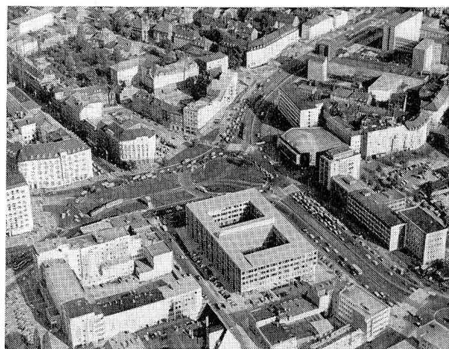
Abb. 1. Hannover, Aegidientorplatz, ein 1951/52 ausgebauter Eckpunkt des innerstädtischen Verkehrssystems (aus «Neues Bauen in Hannover», Aufnahme H. Koberg, Hannover).
