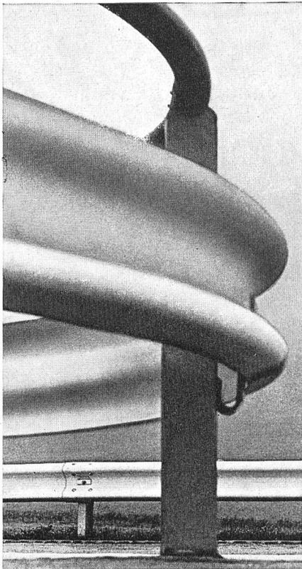
aus 3 mm dickem Bandstahl, im Vollbade verzinkt, daher solid, korrosionsbeständig
