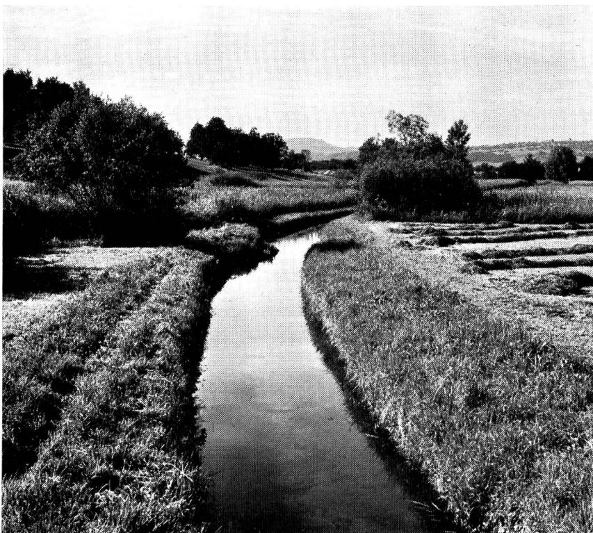
Abb. 13. Büelmüli Aristau-Althäusern: Naturnah geführter und gut gepflegter Entwässerungskanal im Bereich des geplanten Reservates «Aristauer Halbmond». Die Sohlenhöhe des Kanals bleibt unverändert
