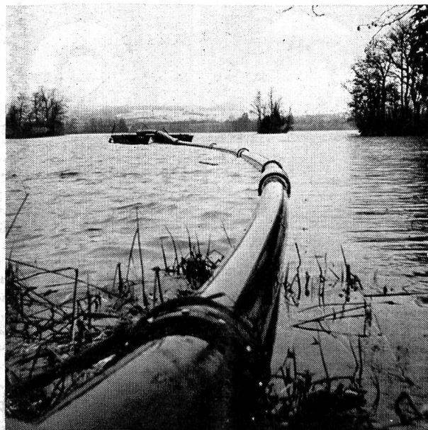
Sanierung des Mauensees: Heberleitung aus Rollmaplast-Hartpolyäthylen-Rohren Durchmesser 315 mm
