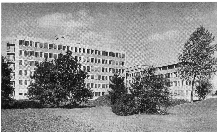
Der Neubau der EAWAG in Dübendorf; links der Labortrakt, rechts der Bürotrakt (Photo: Georg Stärk)
