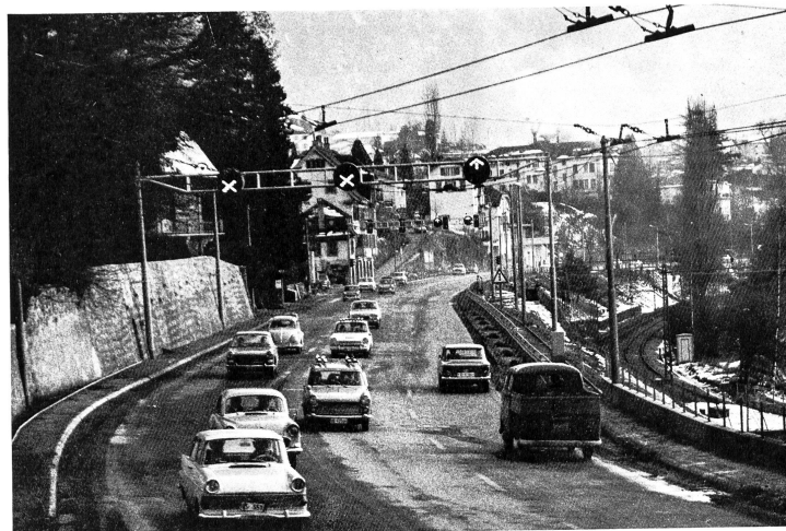
Abb. 5. Spursignalisierung wie sie neuerdings in Deutschland eingeführt wird (mit nach unten zeigendem grünen Pfeil). Das Bild zeigt die Strasse Montreux-Villeneuve 1965. (Bilder Hasler Signal AG.)
