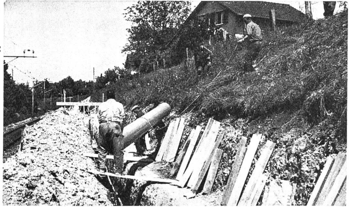
KALIDUR-Kanalisationsrohre, verlegt im Bahneinschnitt
