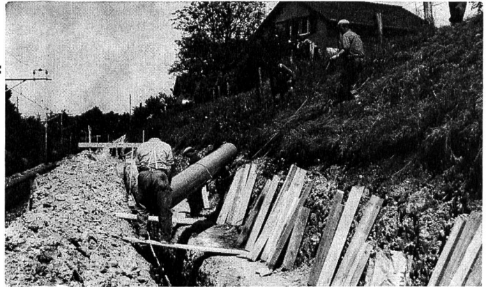
KALIDUR-Kanalisationsrohre, verlegt im Bahneinschnitt
