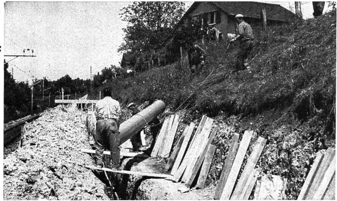
KALIDUR-Kanalisationsrohre, verlegt im Bahneinschnitt
