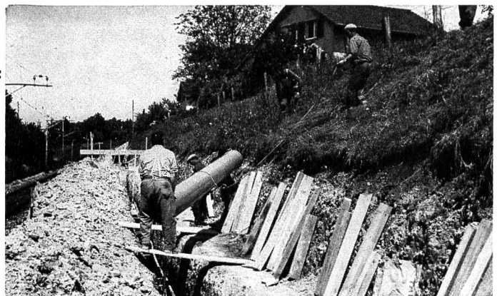
KALIDUR-Kanalisationsrohre, verlegt im Bahneinschnitt
