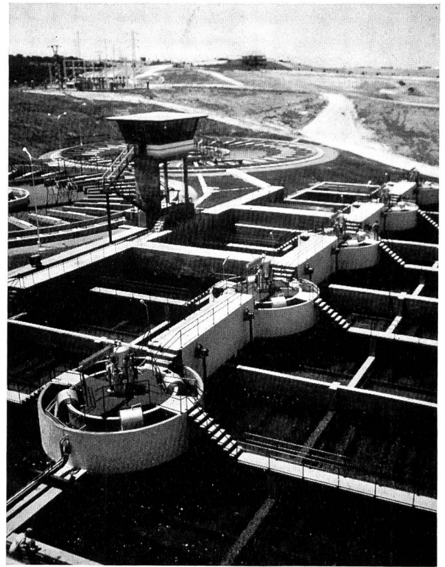
Werkfoto: Stauseewasser für Trinkzwecke. Offene Bauart Chemische Vorbehandlung (Accelerator®) und Feinreinigung in Schwerkraftfiltern System Greenleaf® (keine Ventile und Rohrleitungen)
