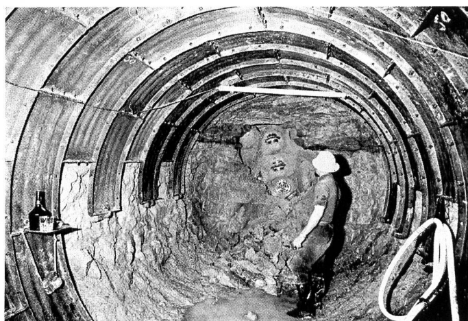
Abb. 2. Stollendurchbruch mit Robbins-Fräse am 28. Mai 1968
