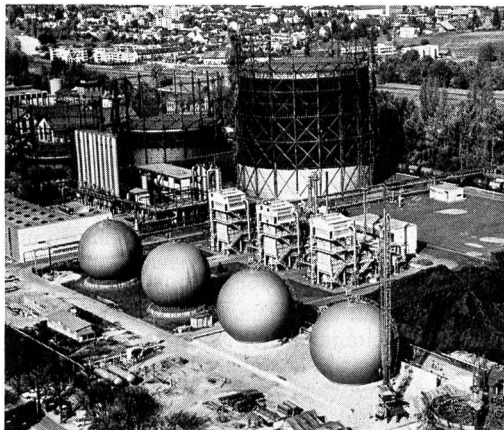
Neuartige Gasbehälter im Gaswerk Schlieren
