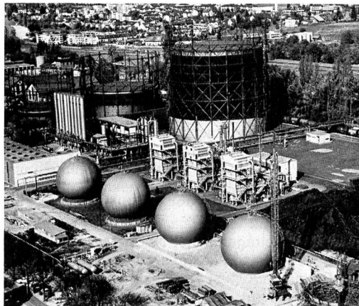
Neuartige Gasbehälter im Gaswerk Schlieren
