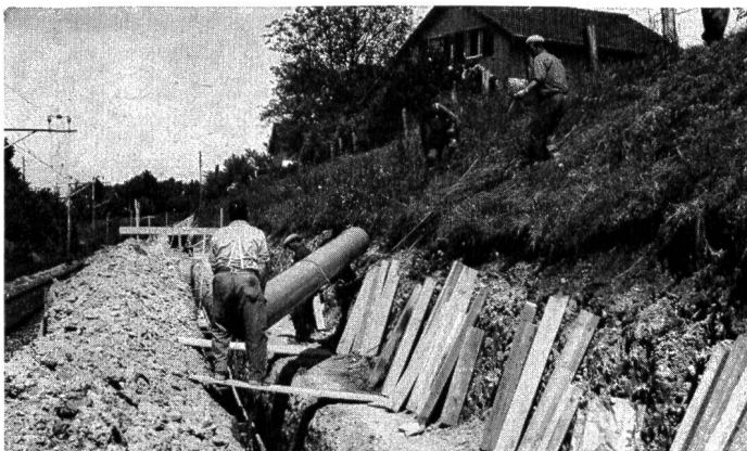
KALIDUR-Kanalisationsrohre, verlegt im Bahneinschnitt
