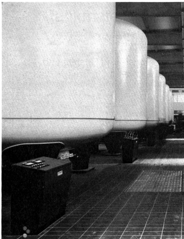
Werkfoto: Rheinwasser (uferfiltriert) für Trinkzwecke Geschlossene Bauart Zweischichtfilter mit nachgeschalteten Aktivkohlefiltern, vollautomatischer Betrieb
