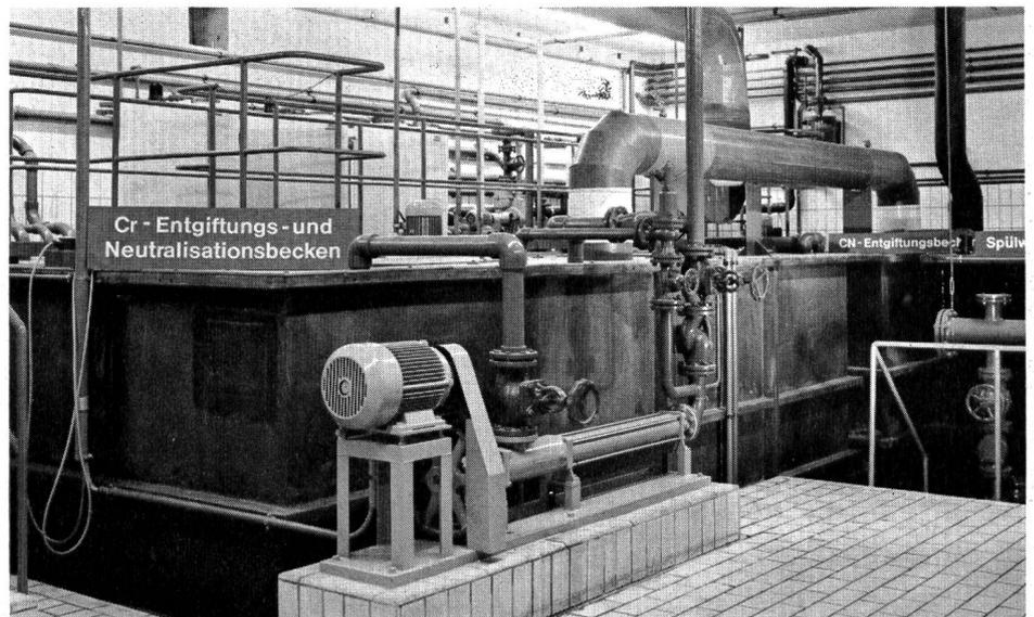
Kanal abgelassen werden kann. Diese Konzentrate werden in 40-m<sup>3</sup>-Behältern, nach Arten getrennt, entgiftet und neutralisiert. Durch die Neutralisation fallen unlösliche Metallverbindungen aus, die auch später nicht mehr eluieren. Dadurch sind die Stoffe in die Form gebracht worden, in der sie einerseits «ungiftig» sind, andererseits meist in der Natur vorkommen.
