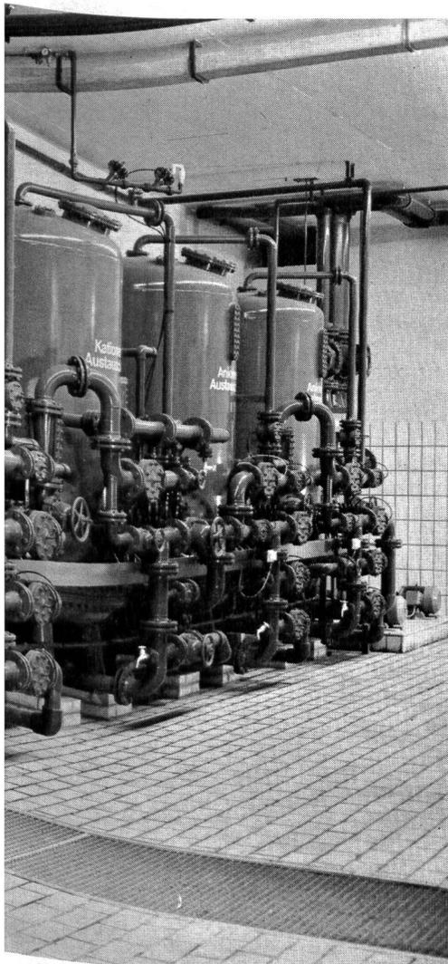
Abb. 1. Ein Blick in die Ionenaustauscher-Kreislaufanlage. Von links nach rechts kann man den Aktivkohle-Kiesfilter (angeschnitten), den Kationen- und den Anionenaustauscher der Strasse 1, den Kationen- sowie den Anionenaustauscher der Strasse 2 und schliesslich den Schlussreiniger erkennen. Ebenfalls ersichtlich sind die Sicherheitsventile für den automatischen Betrieb sowie die Strömungsmesser
