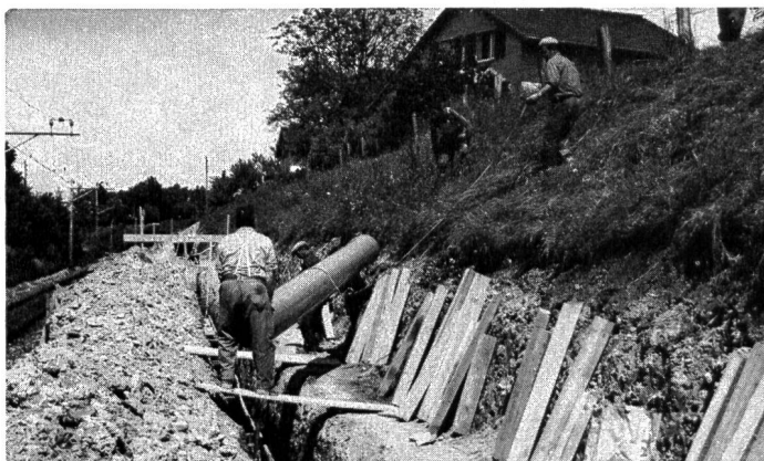
KALIDUR-Kanalisationsrohre, verlegt im Bahneinschnitt
