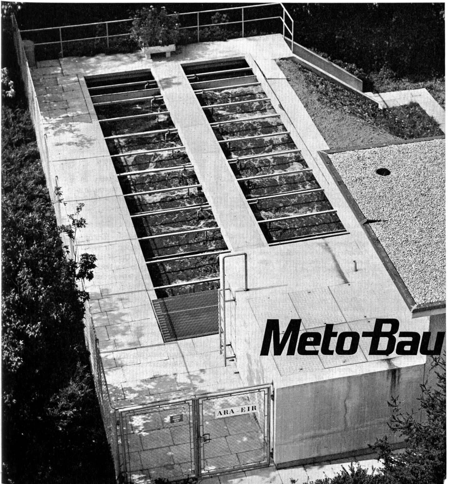
Belüftungsbecken der  $2 \times 60 \text{ m}^3$  Metoxy<sup>®</sup>-Kläranlagen des EIR in Würenlingen für etwa 700 EGW, geliefert 1969 durch die Meto-Bau AG
