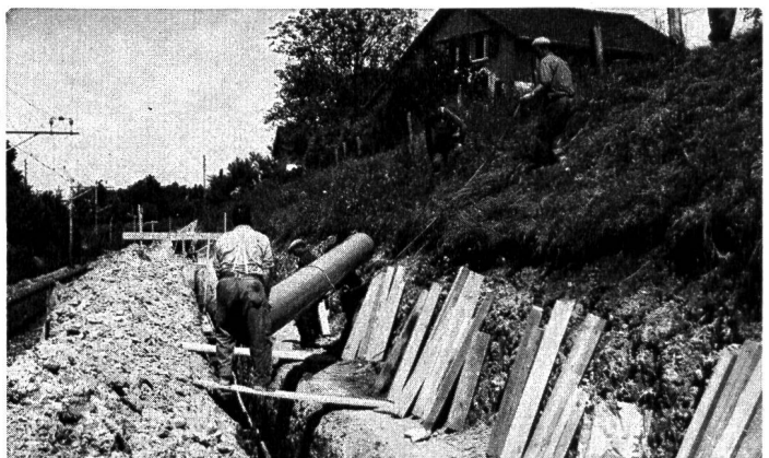
KALIDUR-Kanalisationsrohre, verlegt im Bahneinschnitt
