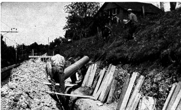
KALIDUR-Kanalisationsrohre, verlegt im Bahneinschnitt
