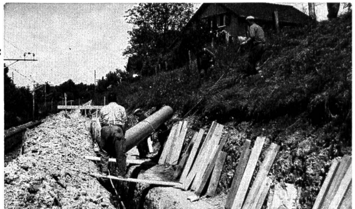
KALIDUR-Kanalisationsrohre, verlegt im Bahneinschnitt
