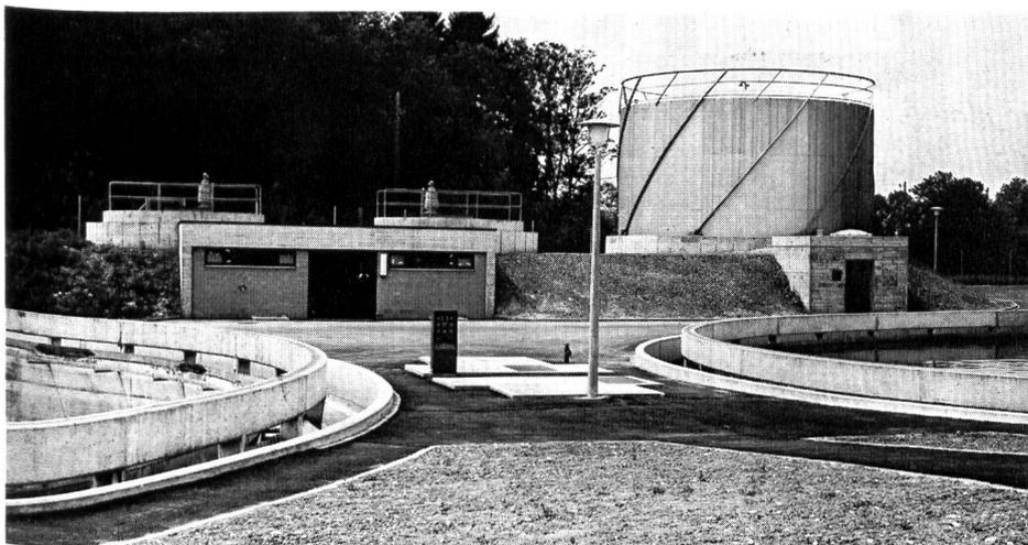
Abb. 2. Die Absetzbecken, im Hintergrund Faultürme und Gasometer mit Maschinenhaus
