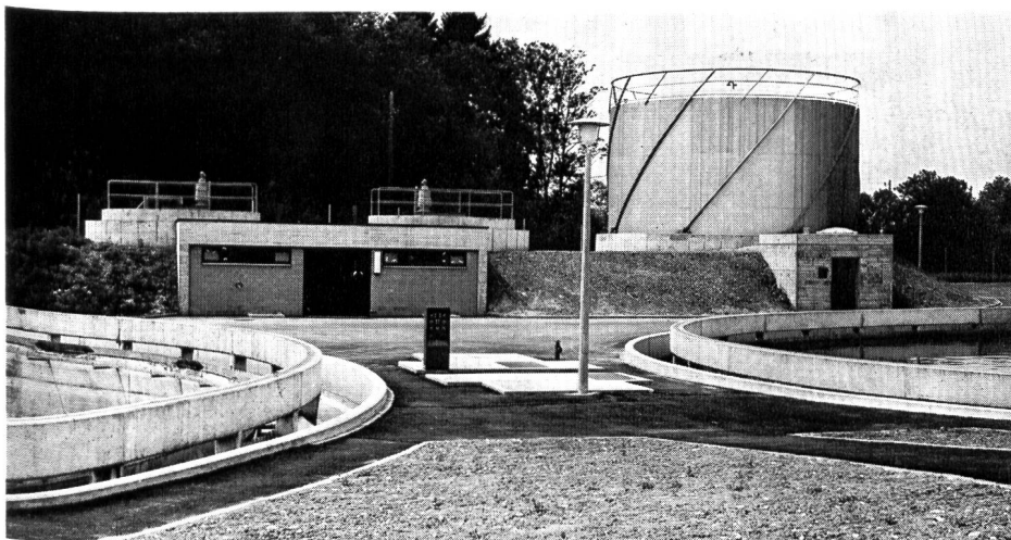
Abb. 2. Die Absatzbecken, im Hintergrund Faultürme und Gasometer mit Maschinenhaus
