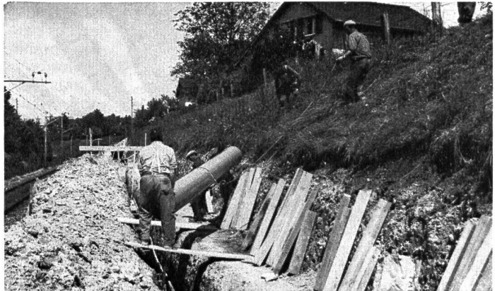
KALIDUR-Kanalisationsrohre, verlegt im Bahneinschnitt
