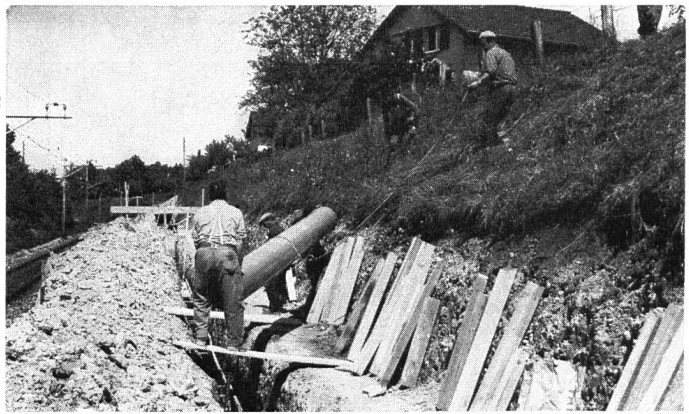
KALIDUR-Kanalisationsrohre, verlegt im Bahneinschnitt
