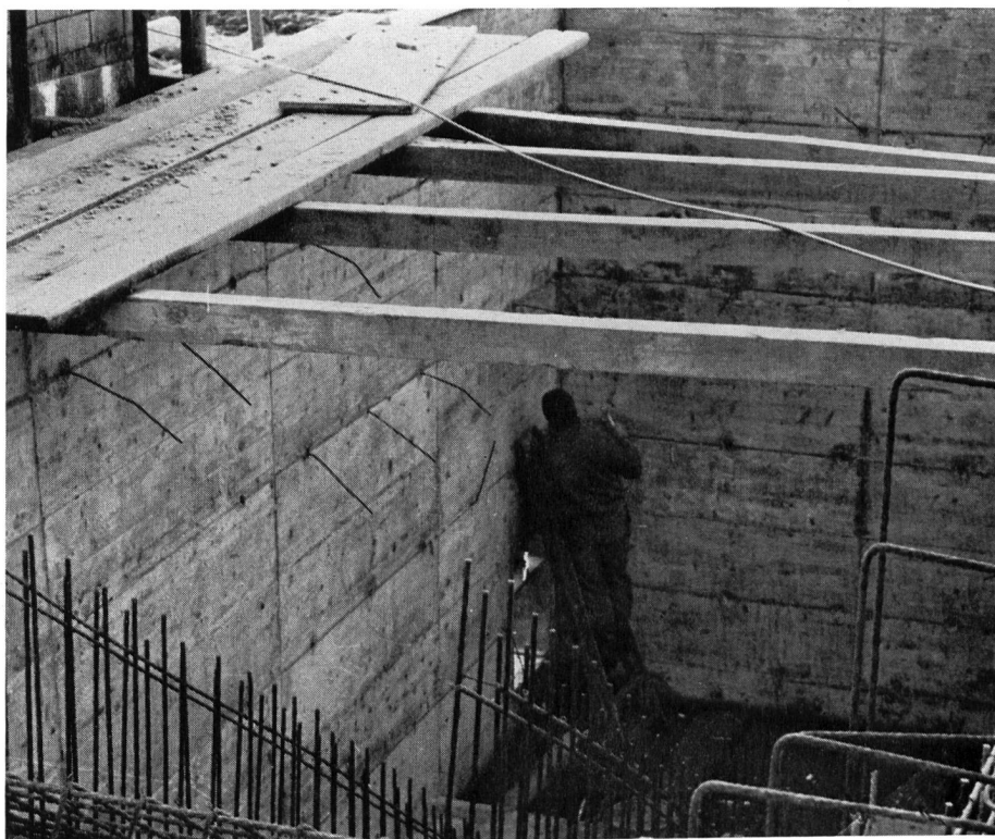
Abb. 3. Regenwasser-Rückhaltebecken
