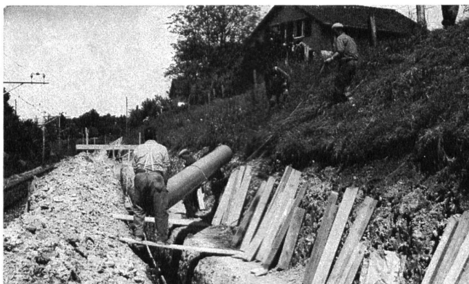
KALIDUR-Kanalisationsrohre, verlegt im Bahneinschnitt
