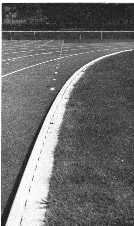
Abb. 4. Leichtathletikstadion Wankdorf Bern. November 1973 — Einbau der Entwässerungsrinnen
