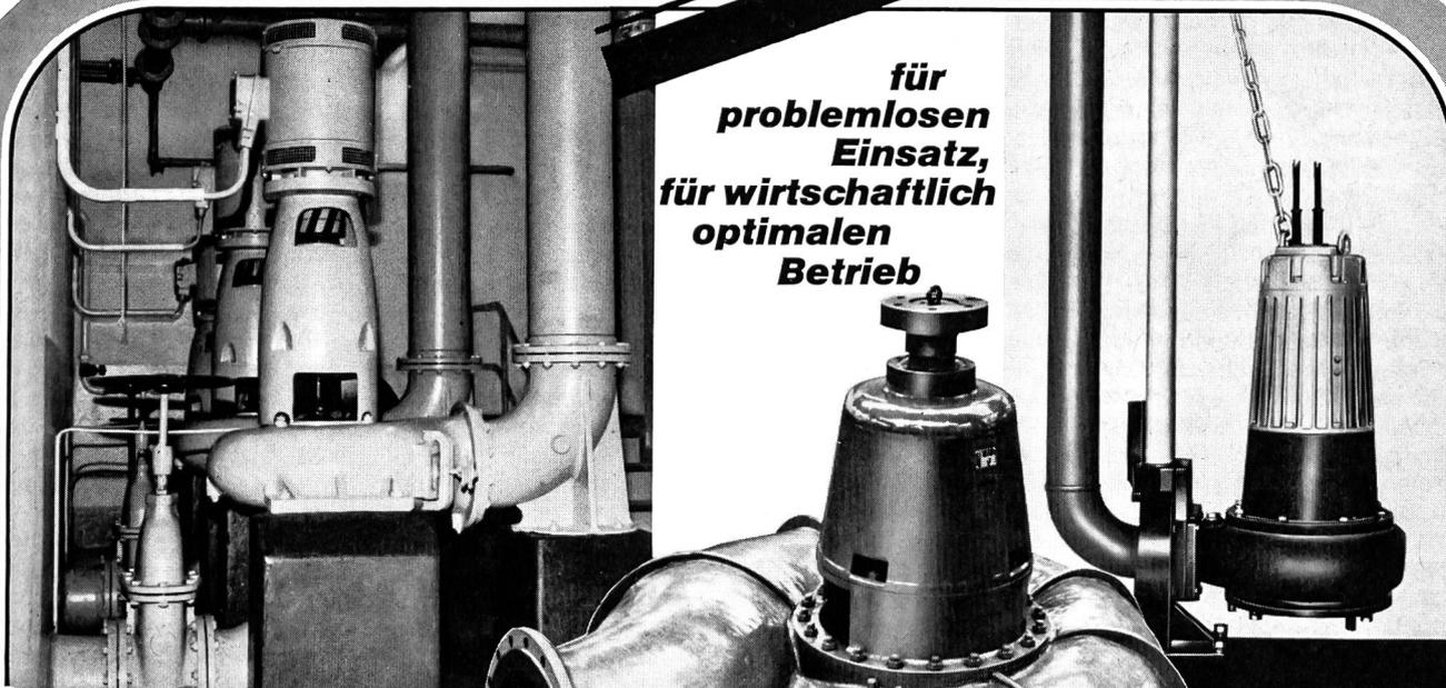
Unsere kleineren Aggregate verfügen über grösstmögliche Durchgangsquerschnitte um die Verstopfungsgefahr auszuschalten – das heisst: Betriebssicherheit. Die grossen Pumpen aber, sie weisen ohnehin weitere Durchflussquerschnitte auf, haben hydraulisch bessere Schaufelungen mit entsprechend höheren Wirkungsgraden. Resultat: niedrigere Stromkosten.
