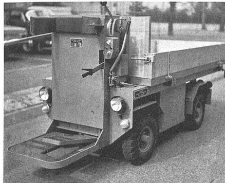
Der oben abgebildete Elektro-Dreiseitenkipper ist ein Beispiel eines solchen Nutzfahrzeuges. Besonders auf Friedhöfen, die heute auch als Erholungsanlagen konzipiert werden, sind Abgasfreiheit und Geräuschlosigkeit sehr erwünscht und somit das Fahrzeug äusserst zweckmässig. Der Kipper ist mit Handhebel steuerbar, von drei Seiten leicht zugänglich und bietet maximale Sichtverhältnisse. Die Handhabung ist äusserst einfach. Je nach Bedarf wird der Kipper in verschiedenen Abmes-
