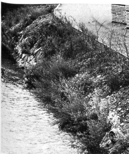
(zu 3.3). Ingenieurbiologie im Wasserbau, zum Beispiel Blockwurf mit Weidensteckhölzern an der Emme in Signau
